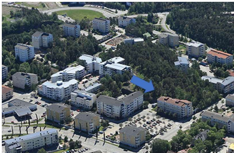
Viistokuva pohjoisen suunnasta. Palvelutalojen rakennukset sijaitsevat Myllykivientien ja Alppilankadun varrella ja Hallinpolun päätteessä, rakennukset ovat julkisivuiltaan vaaleita. Nuoli osoittaa suunnan, johon korttelialuetta on tavoitteena laajentaa.
