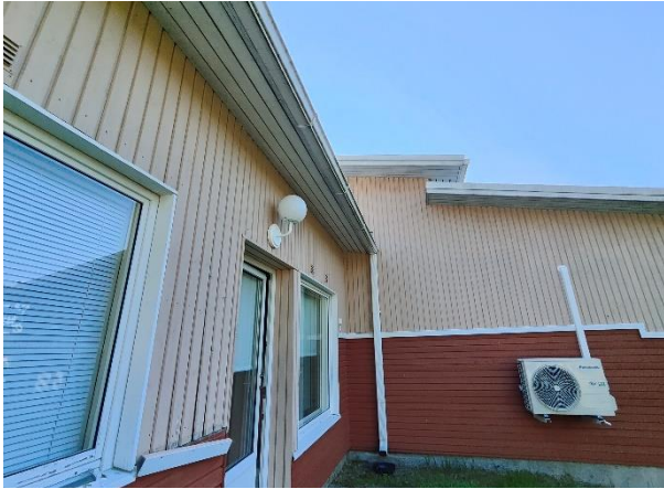
Lähtötietojen perusteella kattosadevesien viemärointi on lisätty vuoden 2011 jälkeen. Sadevesisyökyjen alla on loiskekupit.
