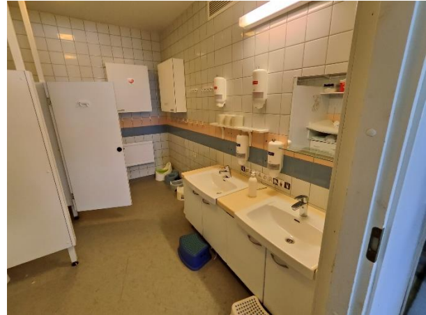
Wc-tilat ovat alkuperäiskuntosia. Lattiasa on muovimatto ja seinissä laatoitus.
