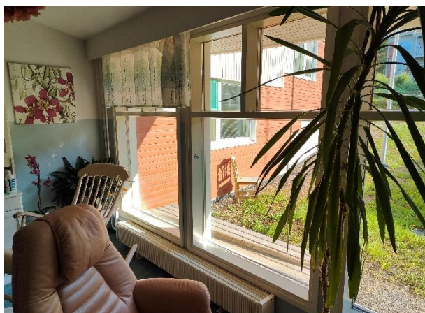
Yleisten tilojen ikkunat ovat kiinteitä kolmilasisia puuikkunoita.
