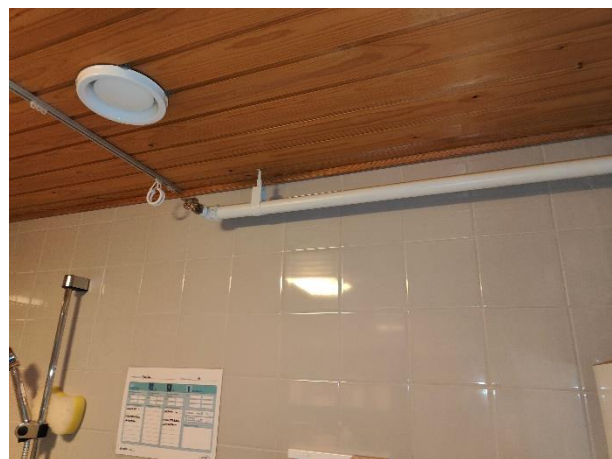
Kylpyhuoneen poistoilmaventtiili
