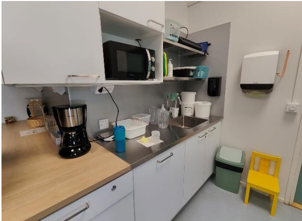
Keittiö on saneerattu laajennustöiden yhteydessä vuosina 2015–2016.
