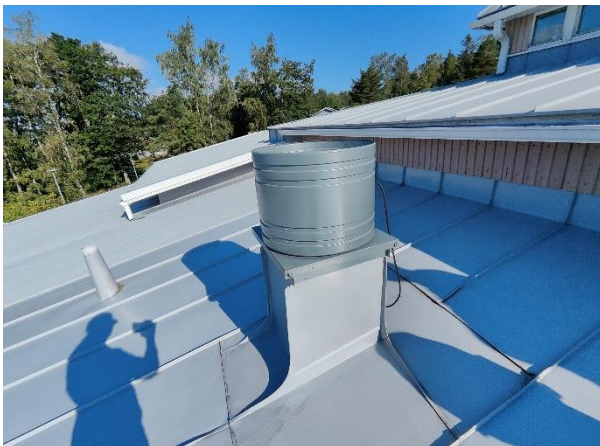
2015 uusittu huippuimuri
