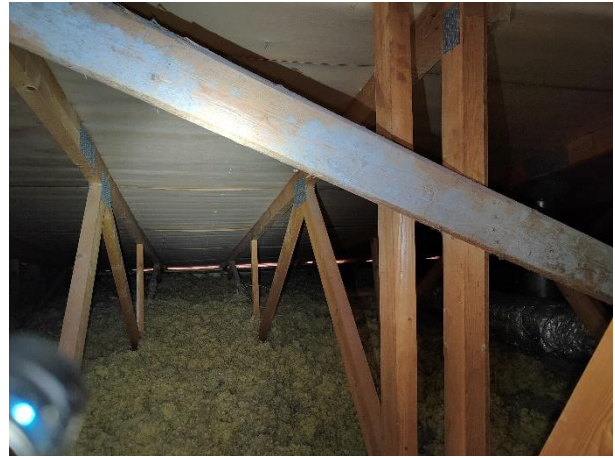
Yläpohjan tuuletuksessa ei havaittu puutteita.
