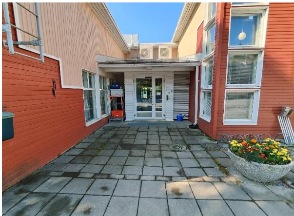
Metalliset pääovet ovat rakenteeltaan hyväkuntoisia ja niiden maalipinta on siisti ja ehjä.
