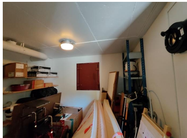
Väestönsuojatiloista on hätäpoistumiskäytävä ulos.
