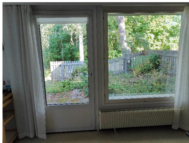
Asuinhuoneiden ikkunat ovat MSE-tyyppisiä sisäänaukeava kaksipuitteisia kolmilasisia puuikkunoita.
