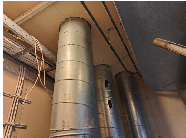
Peltikanavaa ilmanvaihtokonehuoneessa
