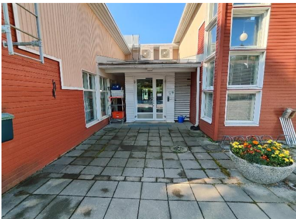
Rakennuksen sisäänkäyntien edustat on laatoitettu betonilaatoin.
