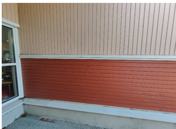
Rakennusten ulkoseinät puulautaverhoituja.
