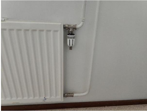
Oras Termostar termostaattiventtiili
