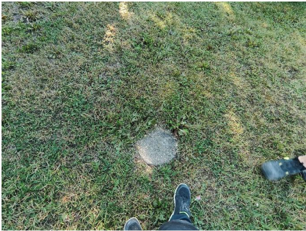
Alkuperäinen salaojan tarkastuskaivo takapihalla.
