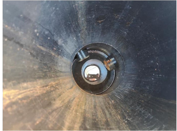
Salaojien tarkastuskaivot ovat näkyvillä. Salaojien toiminnan puutteista ei havaittu viitteitä.
